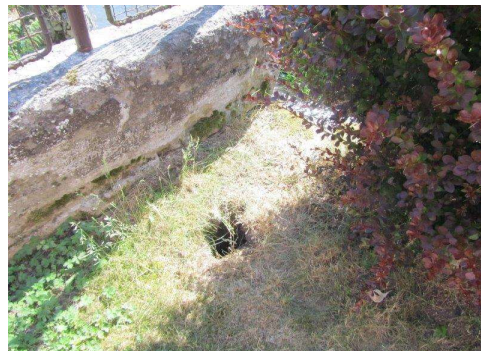
Propad zeminy za poškozenou zdí
